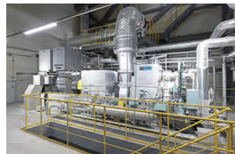
4 蒸気タービン発電機
